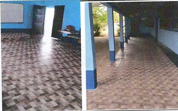
Foto 3: FINALIZACIÓN DE COLOCACIÓN DE PISO
